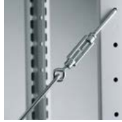
Diagonalstrebe mit Spannschloss
