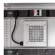
Ventilateur à thermostat et rampe Master centrale dans l'armoire COMFORT
