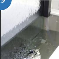
Schalten Sie nun die Wasserwand ein. Bis sich ein gleichmäßiges Fließverhalten zeigt, können einige Minuten vergehen, da die Luft aus dem System entweichen muss. Dies ist normal und kein Fall von Beschädigung.
