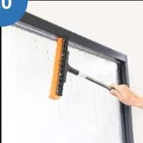
Benutzen Sie den Handwischer aus dem Servicekoffer um den Wasserfilm gleichmäßig zu verteilen. Fahren Sie hierzu die gesamte Glasfläche (insbesondere die Randbereiche) beidseitig ab.
