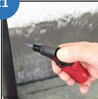
Bleiben nach dem Wischen immer noch kleine Fehlstellen, so können Sie das Glas an dieser Stelle mit dem Brenner aus dem Servicekoffer und dem Edelgas für wenige Sekunden beflammen. Verwenden Sie dazu ausschließlich den Bereich vor der blauen Flamme. Die blaue Flamme des Brenners darf das Glas nicht berühren!
