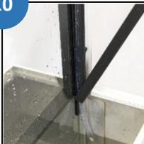
Nun Blenden durch leichten Druck wieder anbringen. Dabei zuerst die Horizontalblende und im Anschluss die Seitenblenden montieren. Seitenblenden zunächst unten auf Wasserbehälter aufsetzen, dann von unten nach oben eindrücken.
