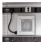
Ventilateur à thermostat et rampe Master centrale dans l'armoire COMFORT
